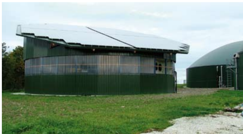
Dieses Gebäude dreht sich mit dem Sonnenstand
